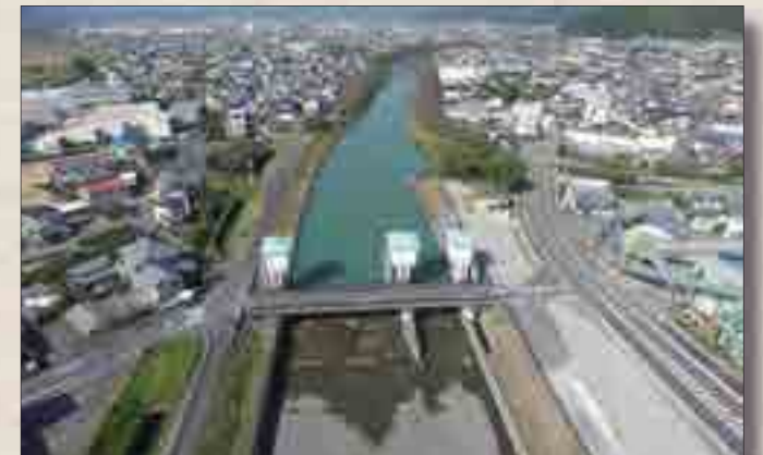
栃山頭首工（下流側より）
