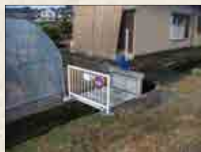
末端用水路の防火施設
