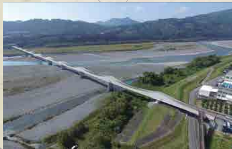
大井川水路橋（左岸下流側より）
