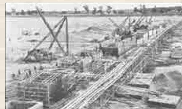
旧大井川サイホン L=828m（昭和 27 年当時）
