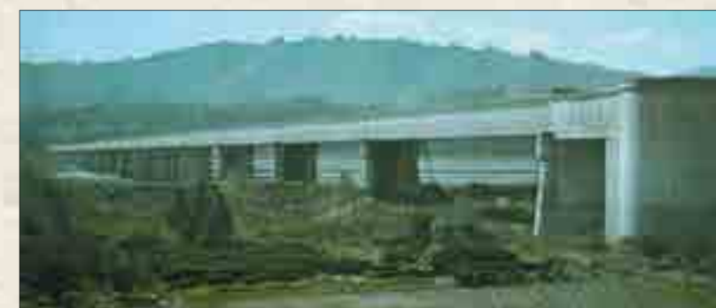
旧大井川水路橋 L=700m
