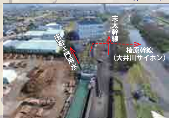
新築した「志太榛分水工」(志太榛幹線水路) (事業概要図 施設番号⑥)
