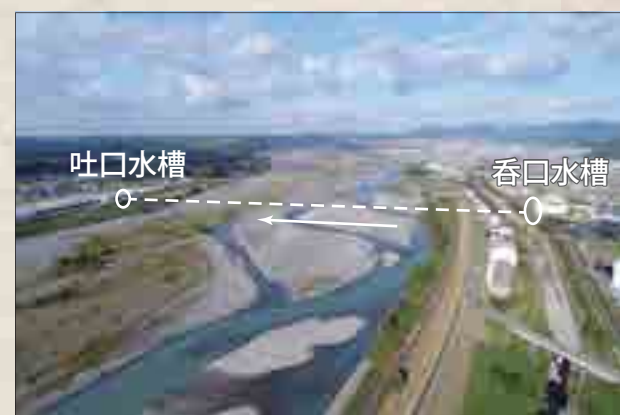
大井川サイホン（破線部）
