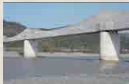
フィンバック※ 3 箱桁橋
