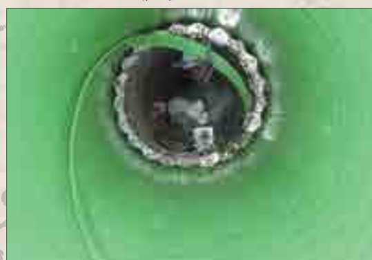
管更生工法により改修した「掛川幹線水路」 (逆川横断工) (事業概要図 施設番号⑫)
