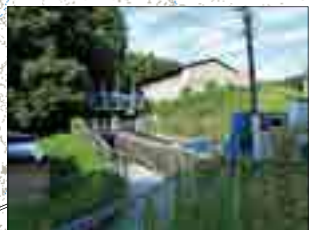
⑪ 伊達方分水工
