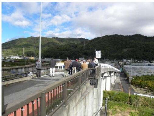
大井川水路橋
