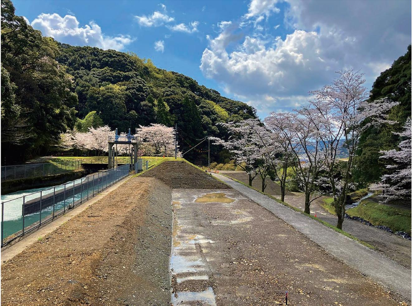
神座分水工は、川口取水口で取水した大井川用水を、志太地域と小笠地域に振り分ける重要な施設ですが、建設から60年経過し、老朽化等により地震発生時の安全率を確保出来ないことが判明したため、分水工横の盛土を使って谷側に押さえ盛土を施工し、安定性を確保する工事を行っています。
